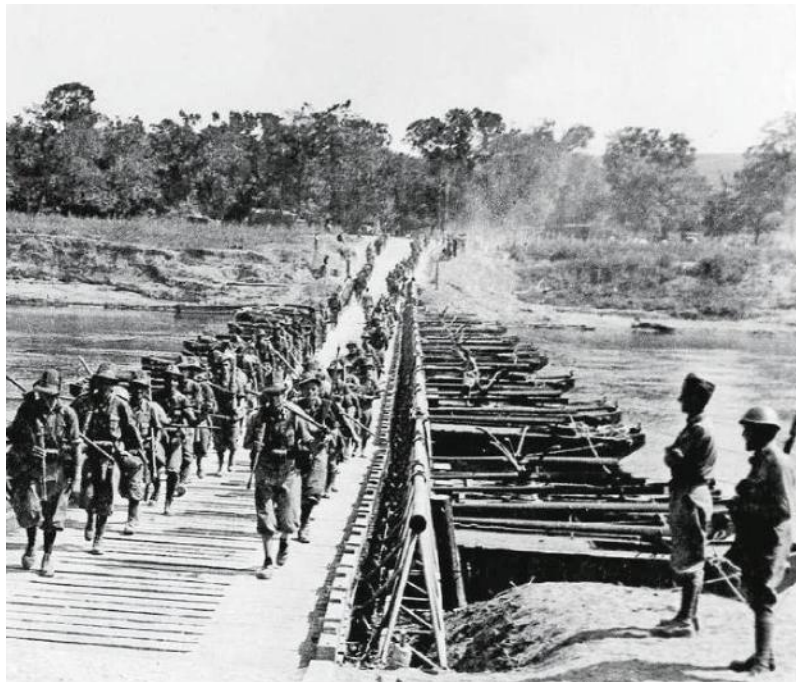
Un ponte di barche costruito dai genieri italiani sul fiume Donez. A sinistra, la copia del diario di Grignaschi.
